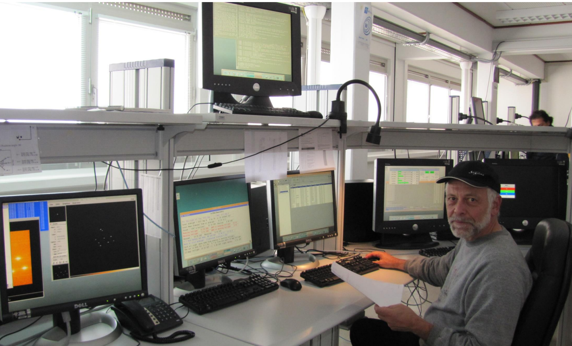
Salle de contrôle des télescopes
