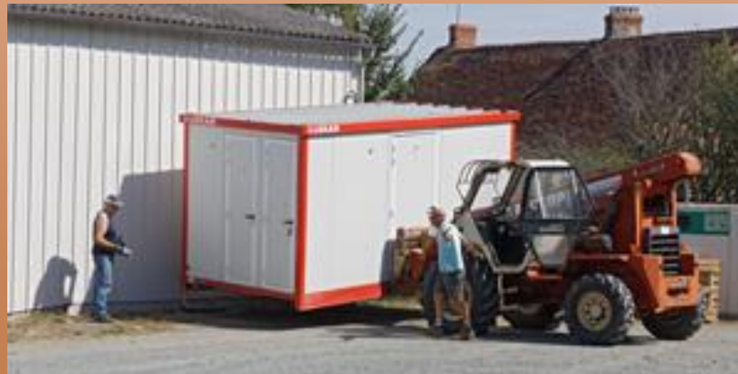
Installation des douches et sanitaires
