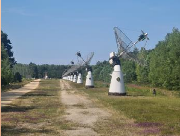
Une partie des 25 antennes paraboliques (Nord-Sud).
