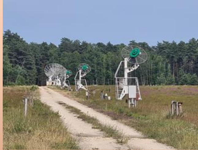
La barre du "T", orientée est-ouest contient 4 paraboles de 5 à 10 m de diamètre, et 15 antennes "lunette".
