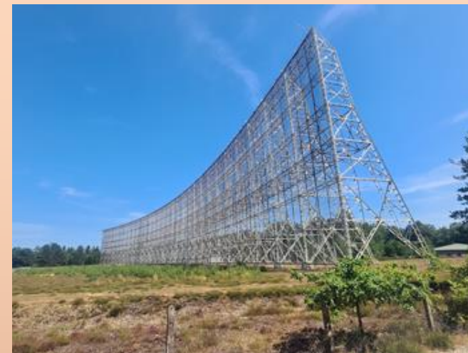
Miroir fixe qui reçoit les ondes du miroir mobile, et les renvoie vers le chariot focal : 40 x 300 m, portion d'une sphère de 1 120 m de diamètre.
