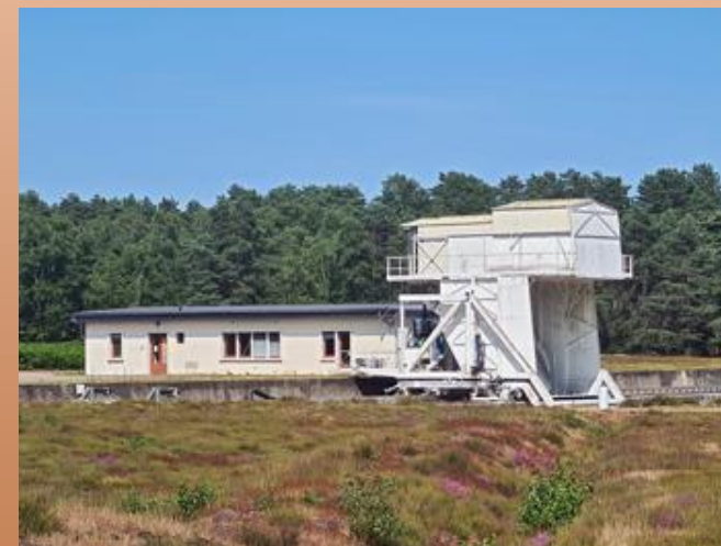
Le chariot focal mobile, antenne réceptrice des signaux pour traitement
