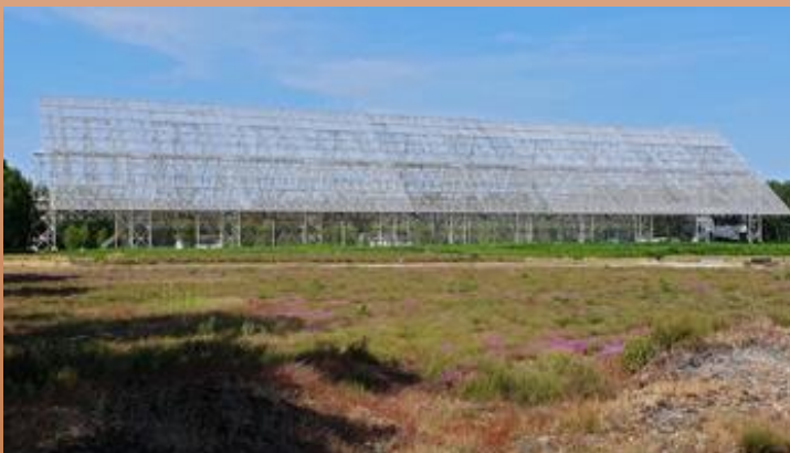
Miroir mobile (40 x 200 m, en 10 panneaux orientables), chargé de renvoyer les ondes en provenance du ciel, vers le miroir sphérique fixe
