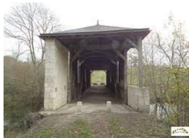
Le pont de bois couvert sur la Bouzanne, unique en France, sur la commune de Pont-Chrétien-Chabenet
